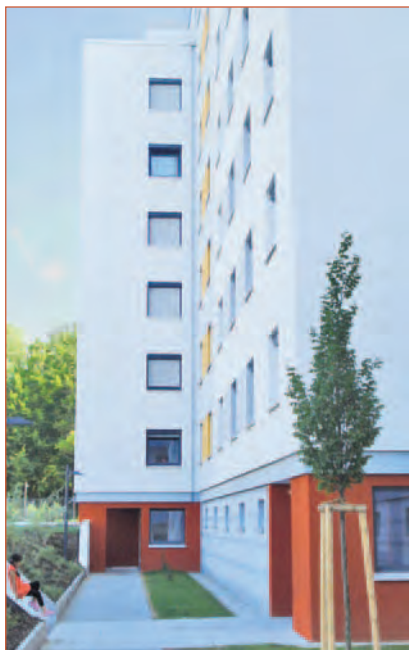
Sanierungsobjekt Baujahr 1970, Eingangsbereich
